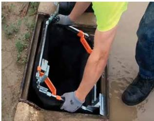
Embone su estructura de Flexstorm® de manera segura.
